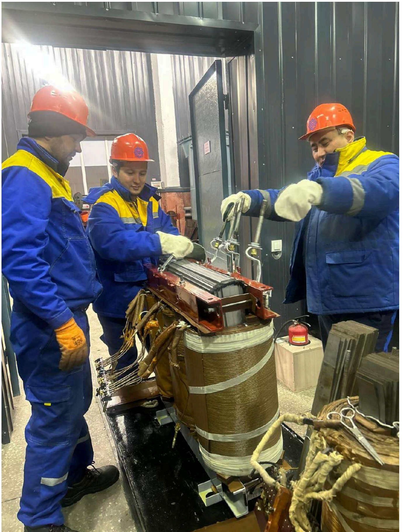
На снимке: Электрослесари цеха по ремонту оборудования ТОО «Жамбылские электрические сети» при капитальном ремонте силового трансформатора.
