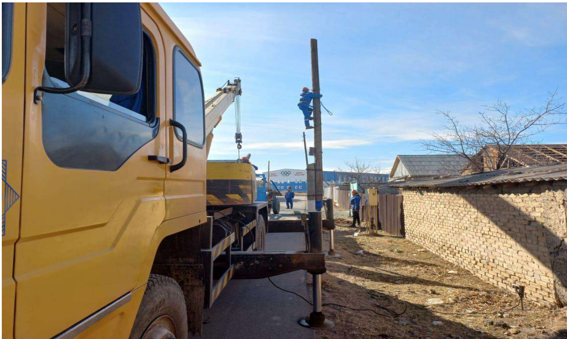
Ремонтная бригада Таразских городских электрических сетей по устранению дефектов после ураганного ветра 17 ноября 2021 года, г. Тараз.
