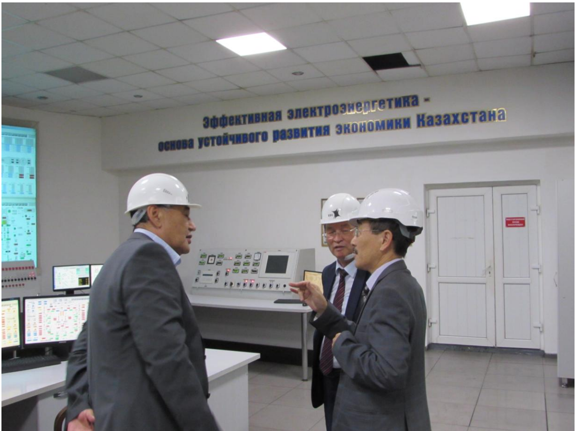
Председатель Казэнергопрофсоюза О. Бекбас с председателем Павлодарского областного профсоюзного центра Н. Рамазановым и главным инженером АО «Евроазиатская энергетическая корпорация» на главном щите управления станции
