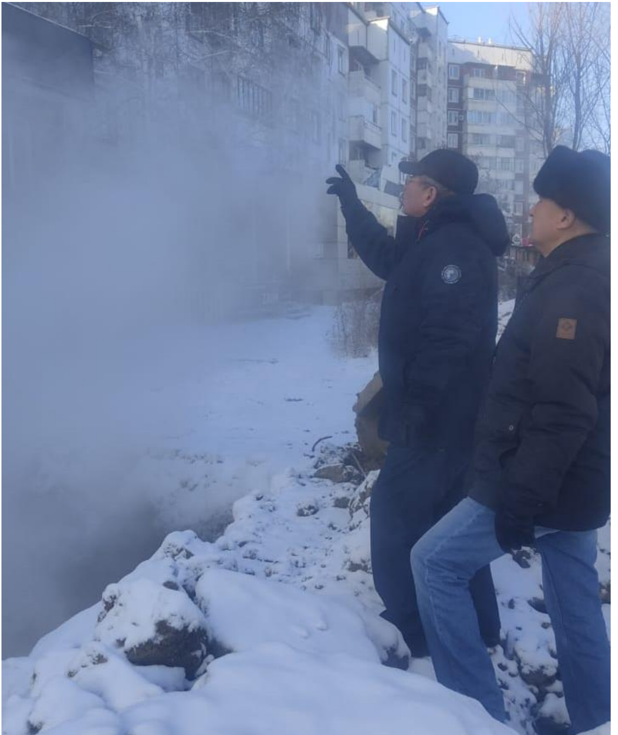
На фото: ремонт придомового теплопровода
